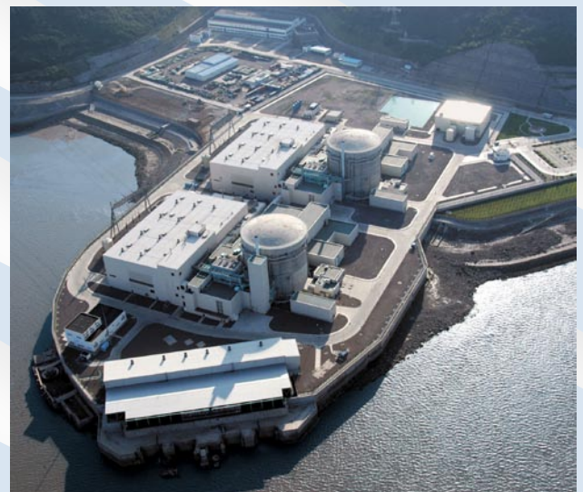
Abb. 1. Das auf der bewährten VME Technologie basierende Sicherheitsabschaltsystem 2 (SDS 2) überwacht die sicherheitskritischen Parameter im Qinshan Phase III Kernkraftwerk in China.
